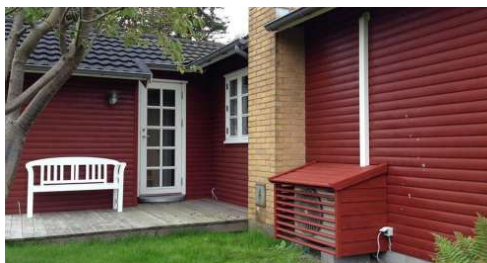
Eksempel inddækning af varmepumpe
